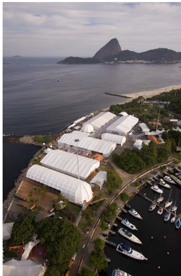
ESTRUTURA MONTADA NA MARINA DA GLÓRIA - RJ
